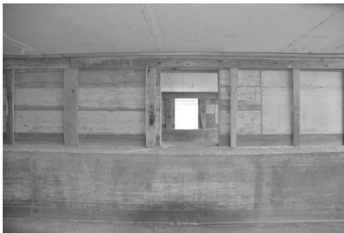
**Fig. 1** – Intercapedine areata al di sotto dell'edificio per il controllo del radon
