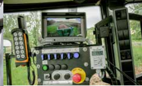
Quadro di comando intuitivo
