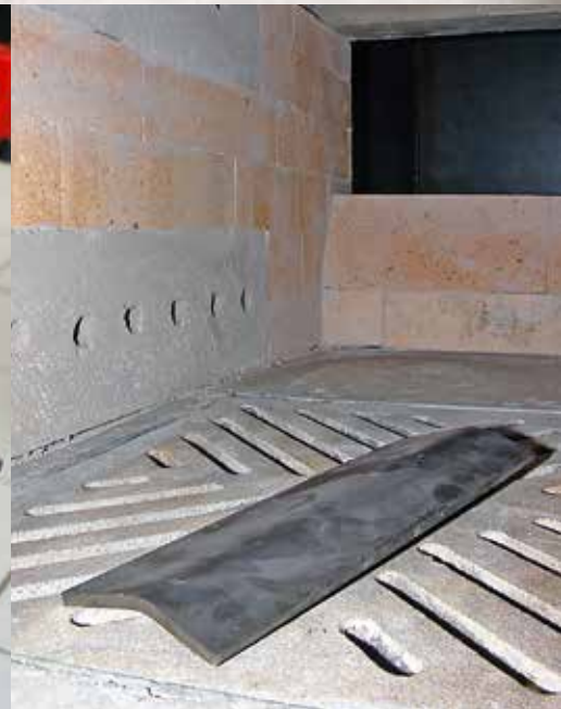
Rimozione ceneri automatica dalla camera di combustione
