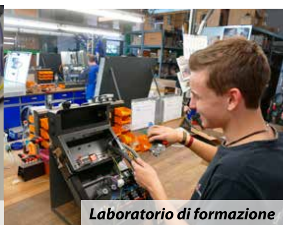
Costruzione del quadro elettrico
