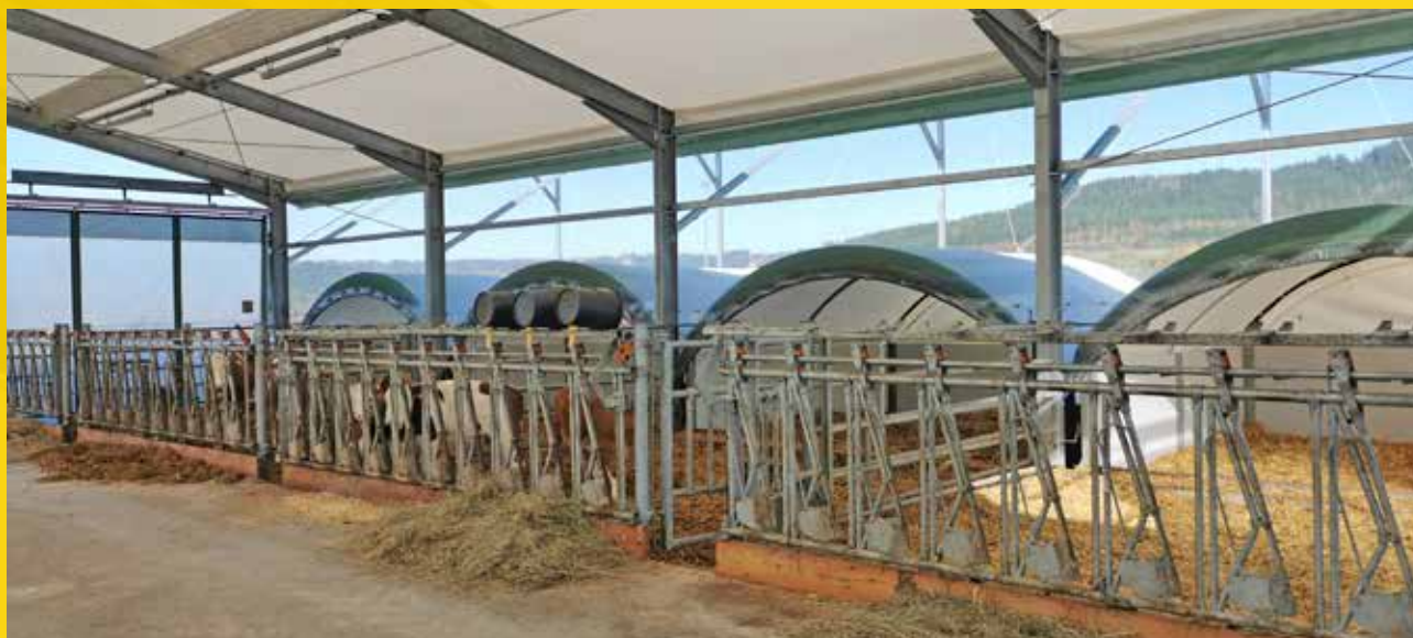
Interno luminoso e condizioni d'aria ottimali
