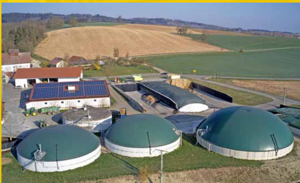
IMPIANTO DI BIOGAS
