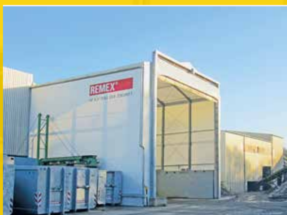
Capannone di riciclaggio
