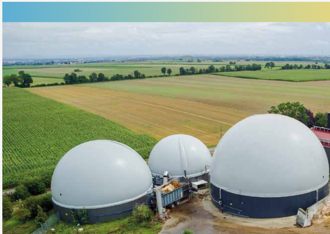
Tre DMGS con sistema Airflow da 550 m 3 , 1210 m 3 e 2590 m 3 di volume stoccaggio
