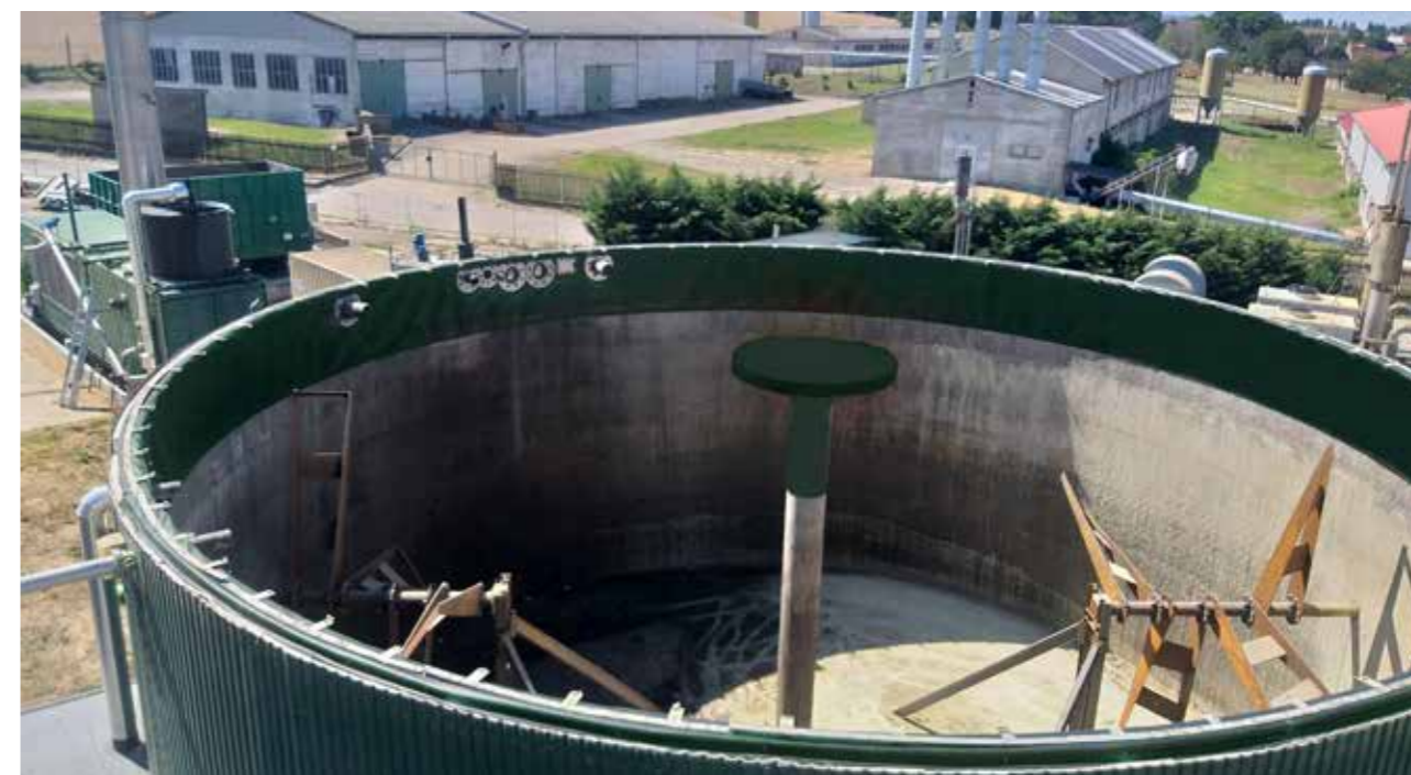
Ristrutturazione della parete di 1 m con penetrazioni nella parete
