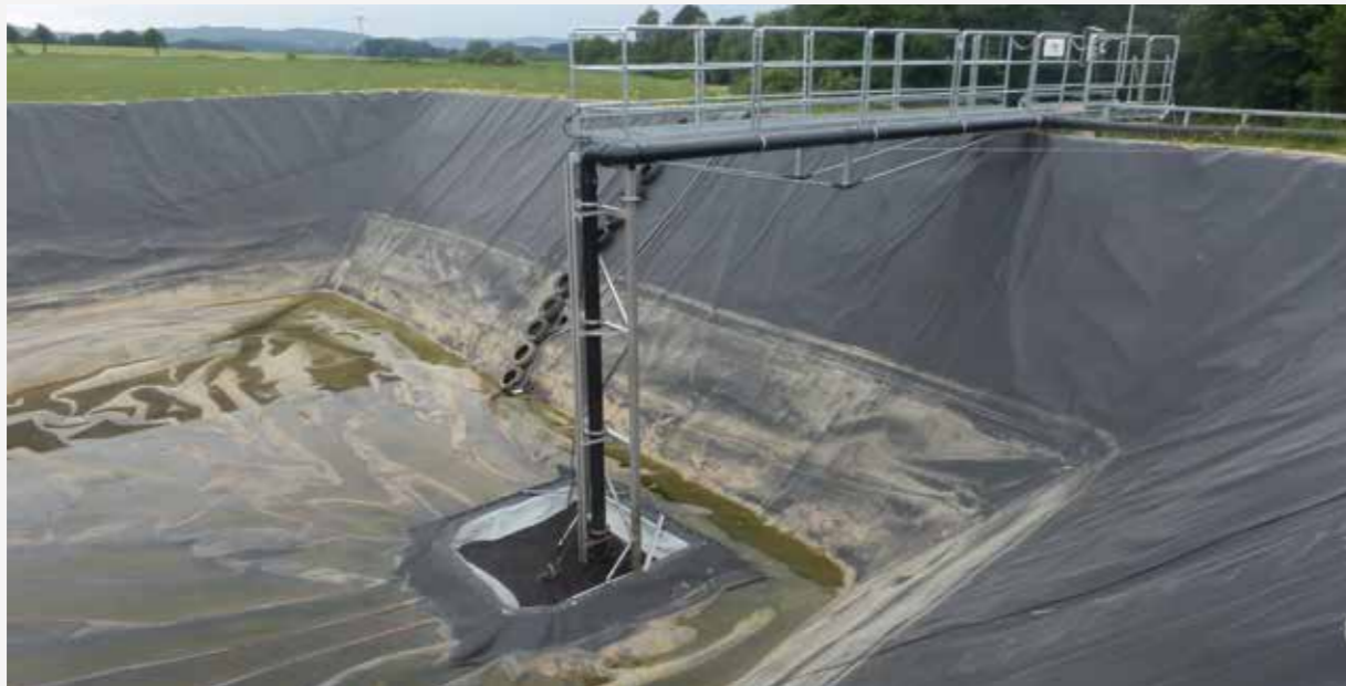
Copertura galleggiante 9300 m 3
