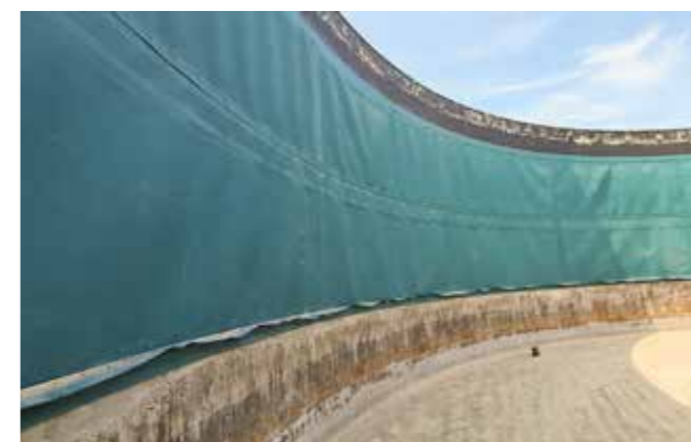
Ristrutturazione della parete 5 m
