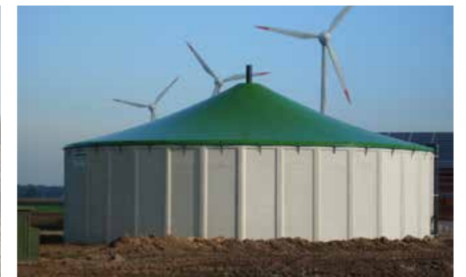
Copertura per biogas su vasca prefabbricata in calcestruzzo
