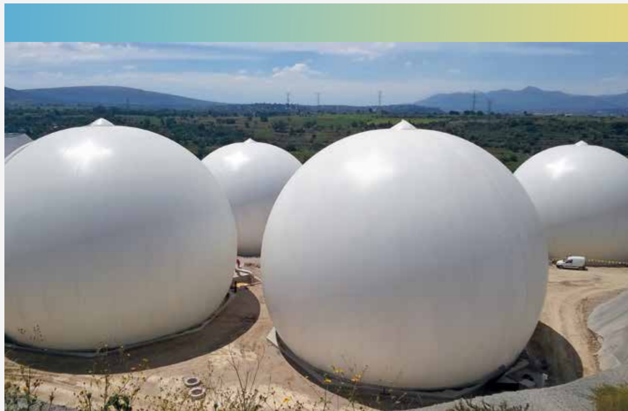
3/4-stoccaggio, 7 volte 8500 m 3
