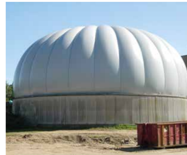
50 %-stoccaggio 2850 m 3 , 35 mb pressione
