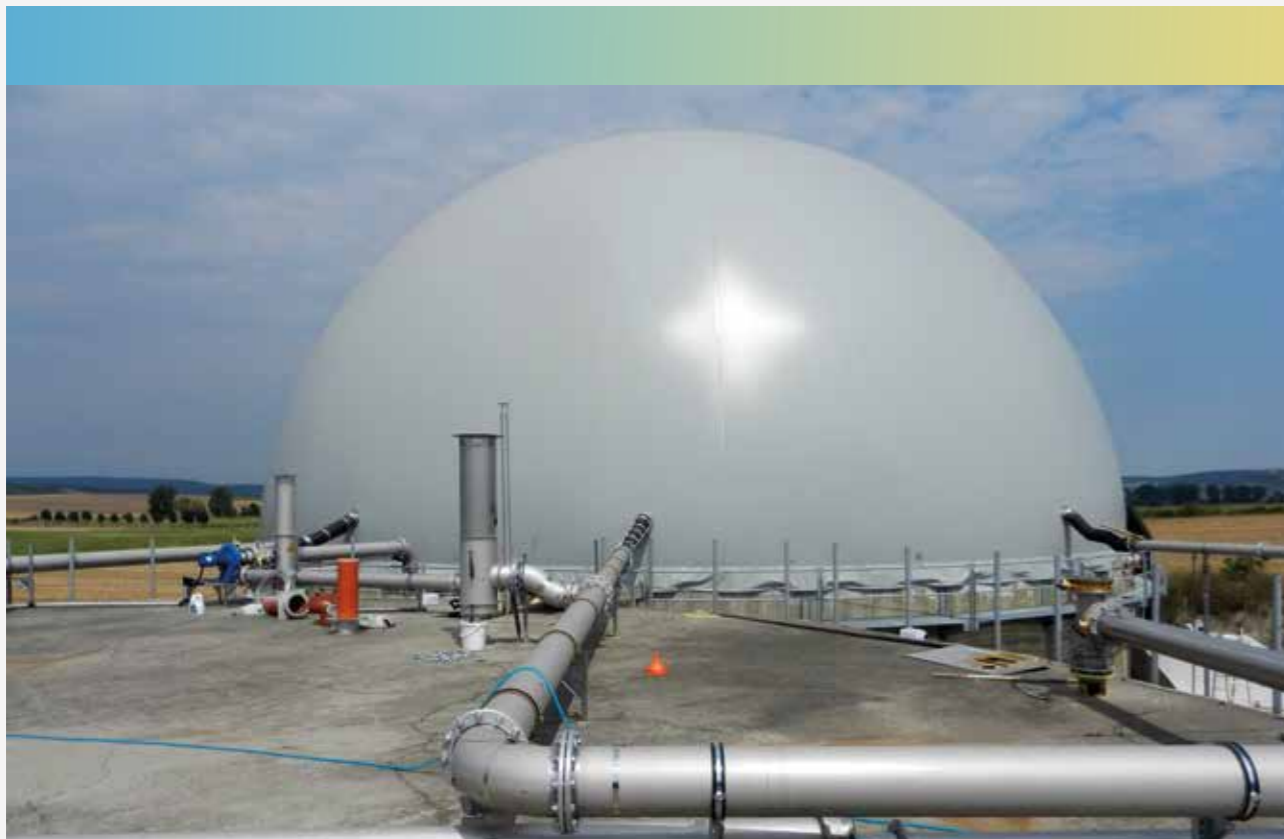
Stoccaggio gas combinato 5600 m 3
