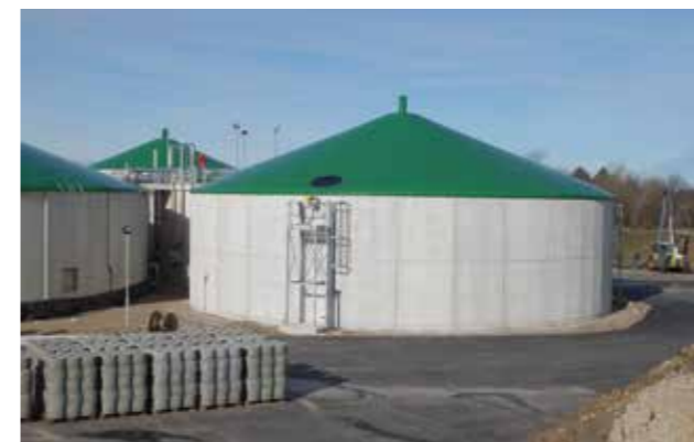
Copertura per biogas su vasca in cemento armato
