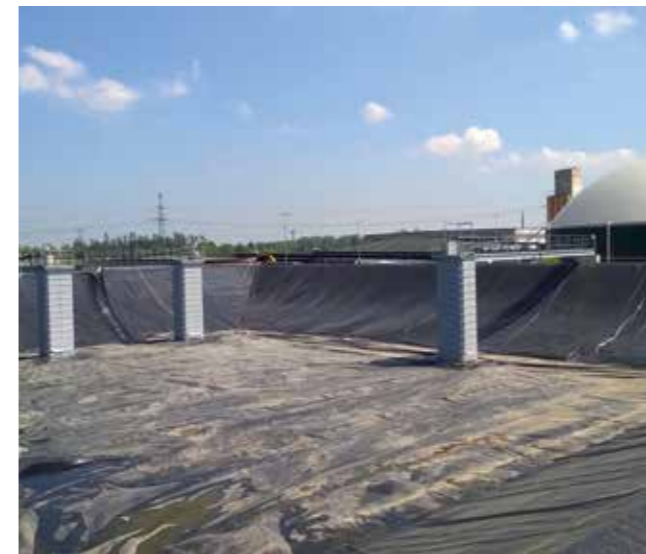
Copertura tessile flottante a tenuta di gas 25000 m 3
