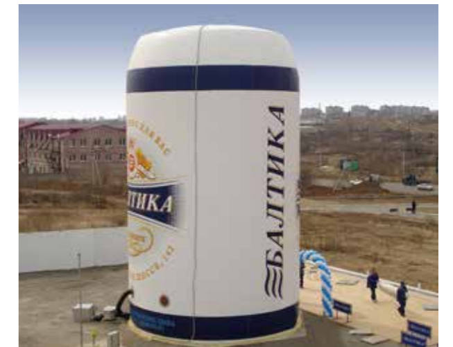
Stoccaggio a forma di barattolo 570 m 3
